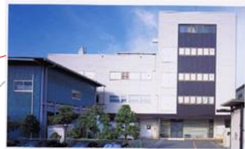
横浜工場 (横浜市神奈川区)
