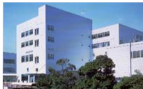
本社工場 (横浜市都筑区)
